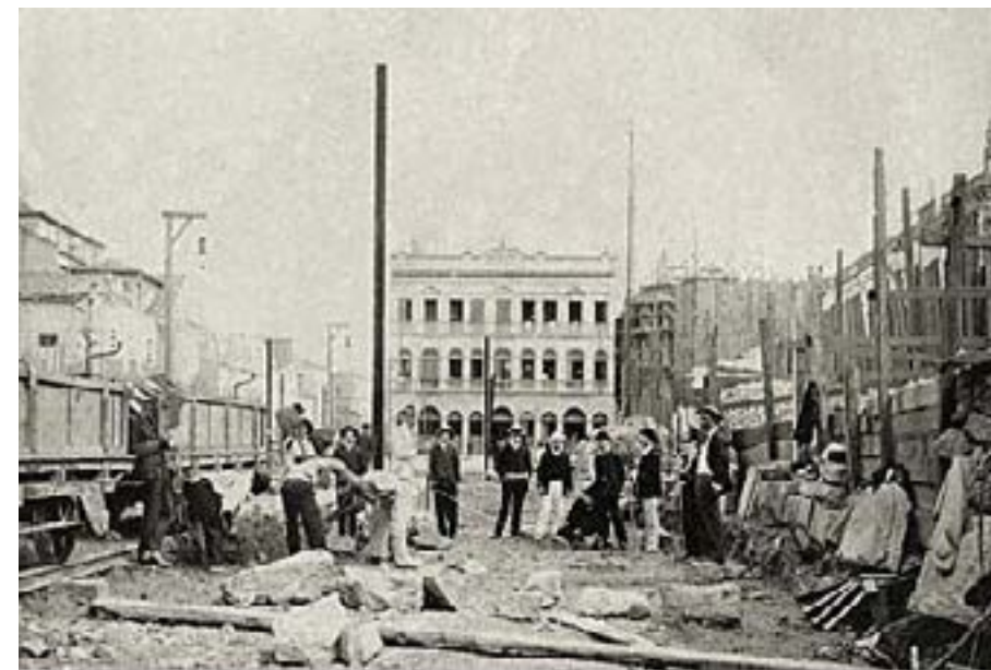
Demolições para a construção da avenida Central, 1904-1905. João Martins Torres – Acervo Instituto Moreira Salles
