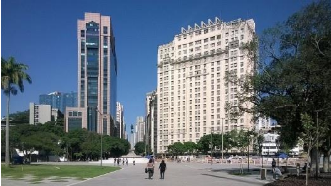
Nova Praça Mauá, edifícios RB1 e A Noite, Rio de Janeiro Foto Masao Kamita
