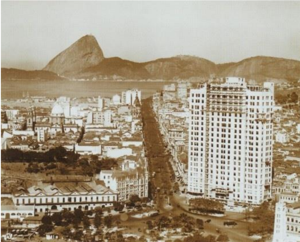
Praça Mauá com o Edifício A Noite, Rio de Janeiro, c.1929
